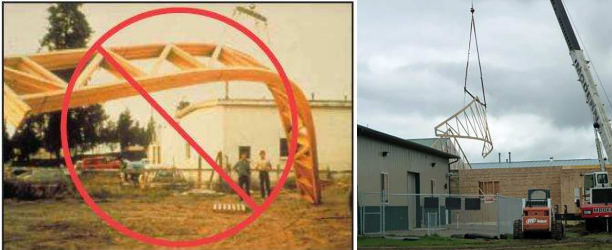
Rys. 28. Kratownica w trakcie montażu
