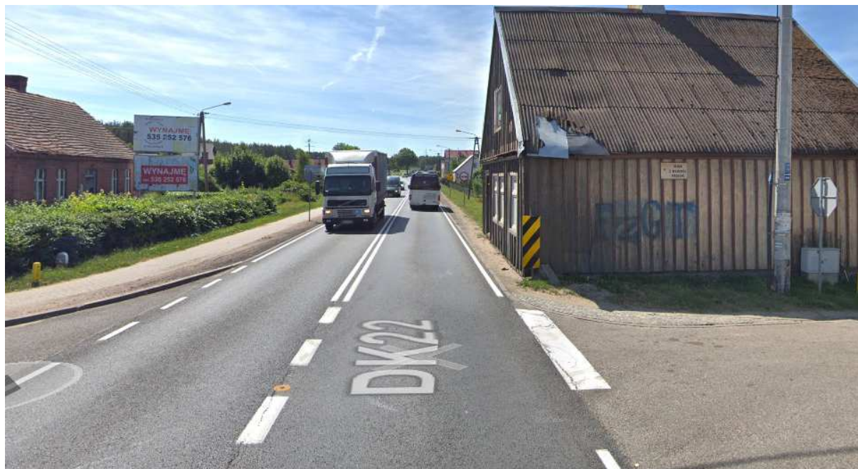
Rys. 20. Zwężenie skrajni drogowej budynkiem
